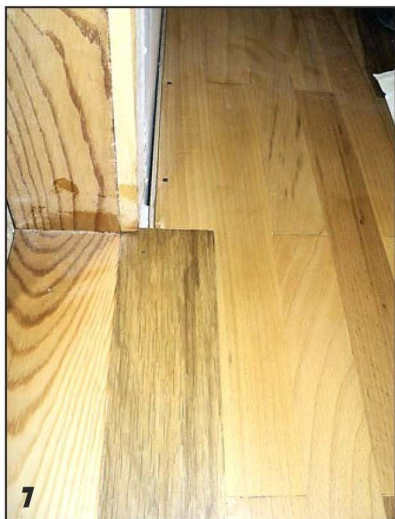
7 Первой была уложена широкая дубовая плашка в дверном проёме в качестве базовой, а от неё уже — все остальные (фото сделано после завершения работ).
