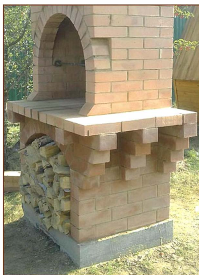
Опоры полок выполнены напусками кирпича в рядах под ними.
