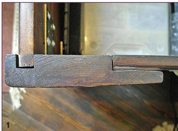
1 Хорошо видны пазы в стойках для установки панелей (вид сверху).
