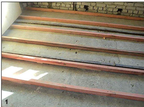
Лаги перед установкой обработал пропиткой от плесени.
