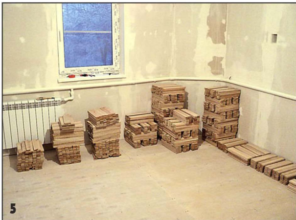
Плашки занёс в спальню для сортировки и отбраковки.
